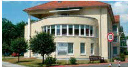
Wohnpark Am Töpferdamm (II)
